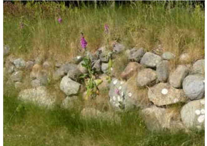
Ulfborgs dige er godt for planter og smådyr – og for øjet. Jordsatte dige er bedst sikret mod erosion og udskridning når de er bevoksede med græs, bregner og blomster.
