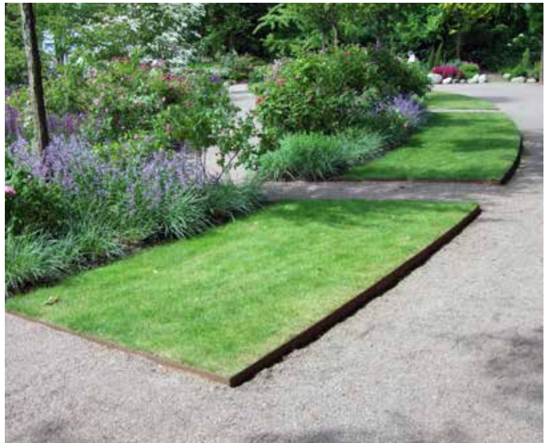
Brug af stålkanter giver skarpe adskillelser mellem græs og stier i Trädgårdsförenings have i Göteborg.
