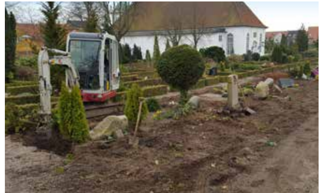
Opravning af hække og planter.
